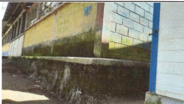
Foto 11: Reparación de muro de contención
