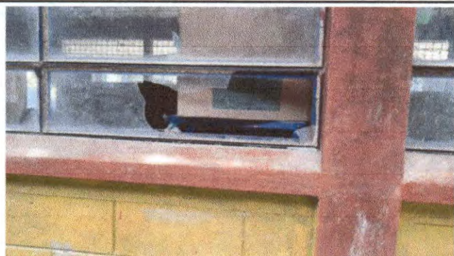
Foto7: Sustitución de vidrios
