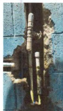
Foto 4: Sustitución de tubería línea principal
