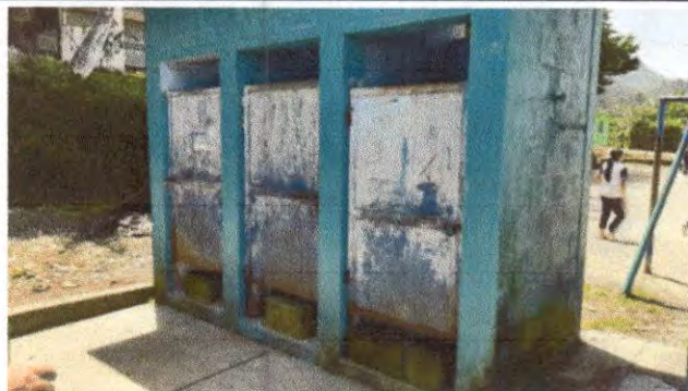
Foto 2: Sustitución de puerta en servicios sanitarios
