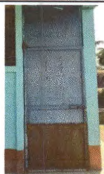
Foto 6: Sustitución de puerta ( 3 X 1 metro)
