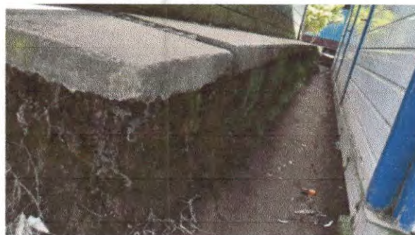
Foto 10: Reparación de banquetas de concreto
