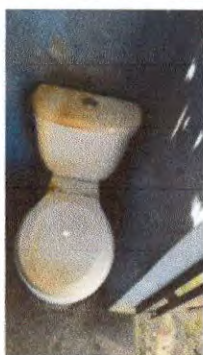
Foto 3: Sustitución de inodoro
