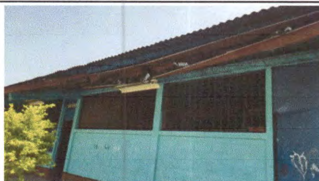
Foto 8: Sustitución de canal de metal
